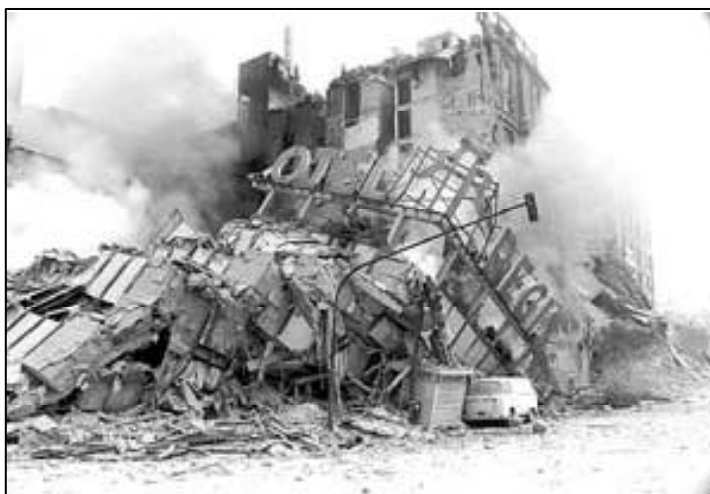
Figura 62. Colapso del hotel Regis de la Ciudad de México, a consecuencia del terremoto de 1985 (Fuente: Periódico La Jornada.)
