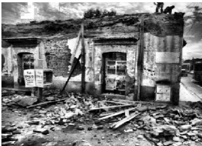
Figura 54. Daños a consecuencia del sismo del 30 de septiembre en Oaxaca, México
