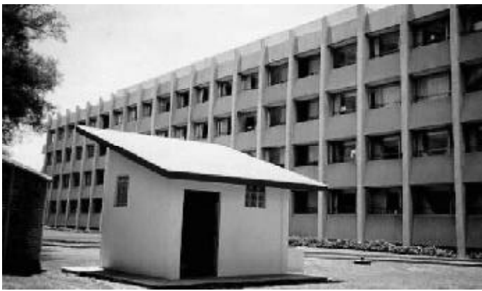
Figura 49. El edificio «Lara Sosa» del Instituto Mexicano del Petróleo IMP se instrumentó con 4 acelerógrafos modelo SMAC-MD y sensores en la base y azotea del edificio, así como un sensor de pozo a 80 m de profundidad (CENAPRED)
